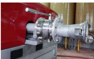
**Kugelhahn für Zentralbefüllung**
